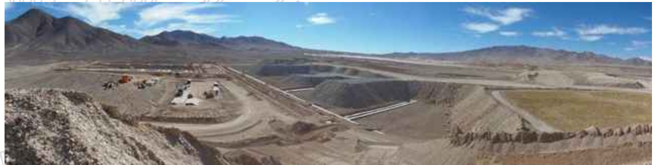
Pila Industrial de Biolixiviación División Radomiro Tomic Codelco 1 millón ton, 0,27% Cu
